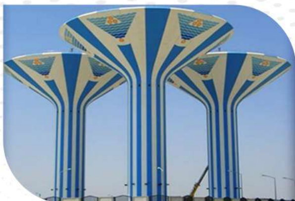
Water Reservoir Réservoir d'eau
